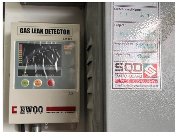
ภาพที่ 2-4 Gas Detector
